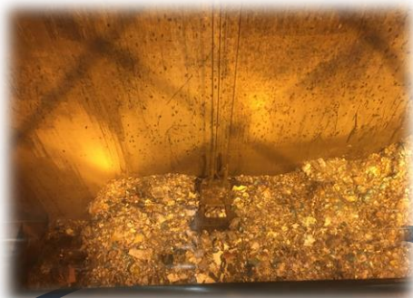
ごみピットの中。攪拌しながらクレーン で少しずつ焼却炉にいれます。
